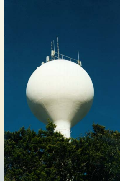
Instalación de antenas en sitios especiales
